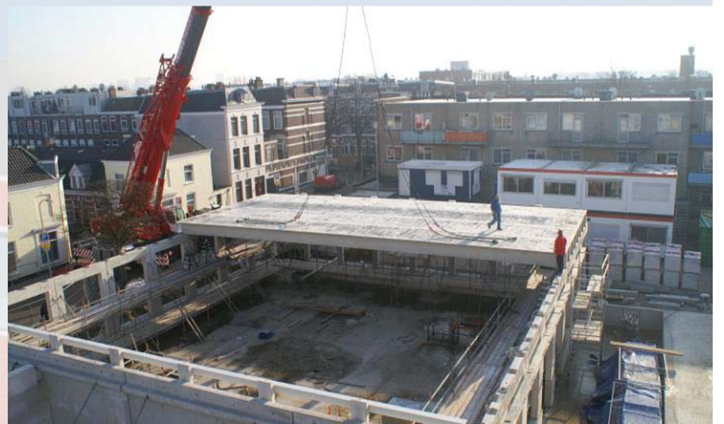
Hier komt straks de gymzaal. Foto: Ed de Bruyn.
