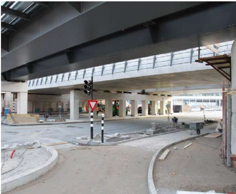
De Put tijdens de verbouwing.
